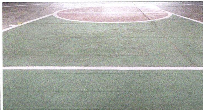
Foto 3: PINTURA EN EXTERIOR Preparacion de la superficie y aplicación de pintura a dos manos, en líneas de cnache y en porteria
