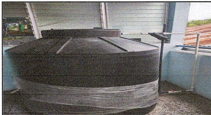
Foto 2: REPARACION MANTENIMIENTO DE CISTERNAS/DEPOSITO DE AGUA sustitucion de cisterna y accesorios de tanque de almacenamiento de
