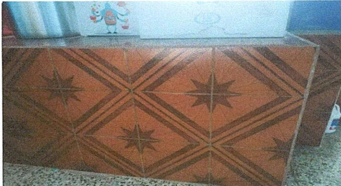
Foto 4: SUSTITUCION DE AZULEJO: sustitución de piso tipo azulejo, trabajo de nivelación, instalación alineada y sizado en juntas. En meson de cocina
