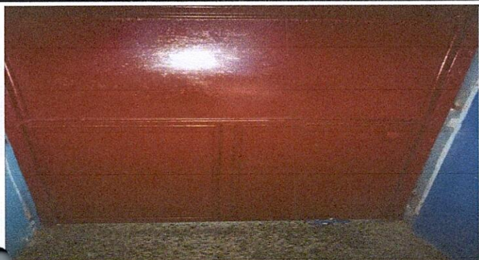
Foto 1: PUERTAS: mantenimiento a puerta metálica existente retiro de óxido, suciedad y pintura deteriorada; incluye cepillado, lijado y aplicación de pintura
